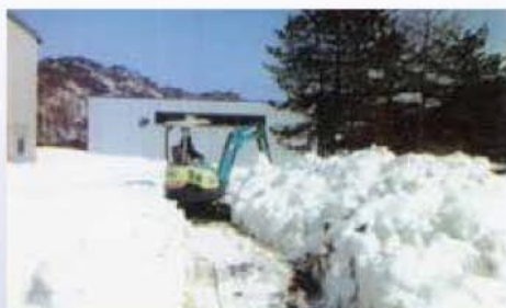
① 重機による除雪作業
