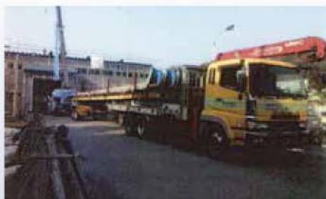
② 大型トレーラーによる搬入作業
