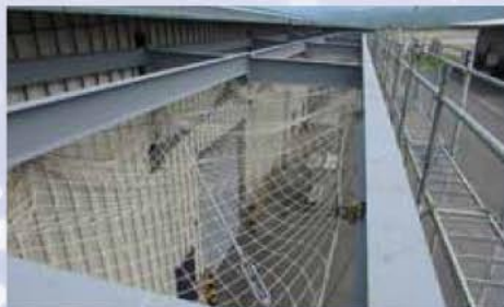
④ 鉄骨フレームの新設
