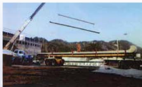
③ 大型クレーンによる荷揚げ作業
