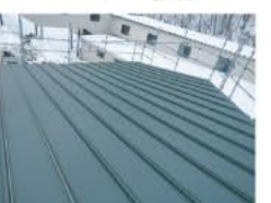
▲縦長尺トタン葺き替え完了
