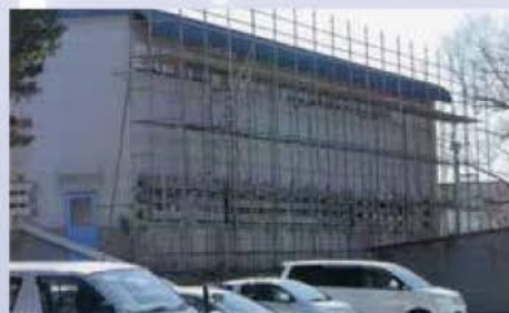
⑥ 施工後と仮設足場風景
