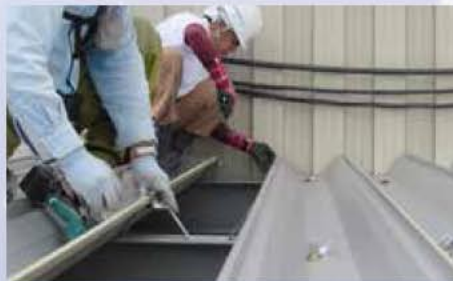
⑤ 折板屋根の施工作業
