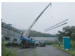
▲屋根材の荷上げ
