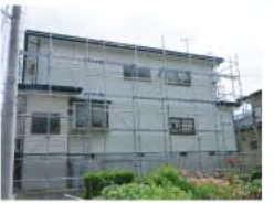
▲雨樋工事をしています
