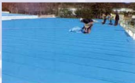
④ 折板屋根の施工風景
