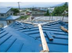
▲屋根の棟交換です
