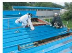
▲新しい折板屋根葺き替え
