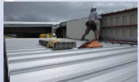
⑥ 屋根と壁のおさめ作業
