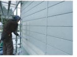
▲外壁塗装の施工風景です
