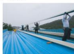
▲既存屋根解体
