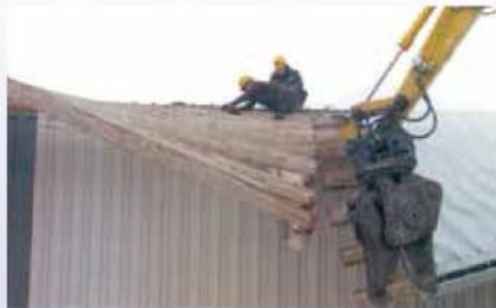
② 鳶職人による解体作業
