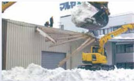
① 除雪及び解体作業
