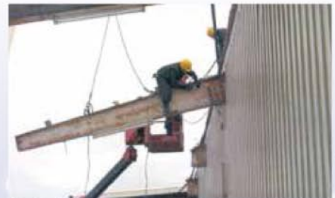
③ 鳶職人による解体作業
