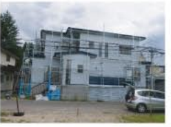
▲全ての工事が完了しました
